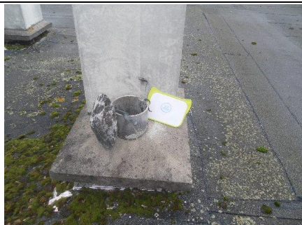
Photo n° PH01 Localisation : Toiture - Terrasse Ouvrage : Conduits, canalisations et accessoires intérieurs et extérieurs - Conduits de fluides (air, eau, vapeur, fumée, autres fluides) Partie d'ouvrage : Conduit Description : 3 Conduits et 2 mitrons
